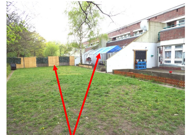
Reparaturen / Instandhaltung von Zaun und Zelt Reinigung des Freigeländes
